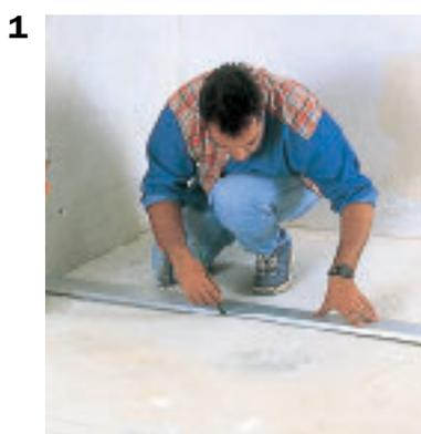
**1. Tracer sur le sol et les murs les emplacements des cloisons.**
