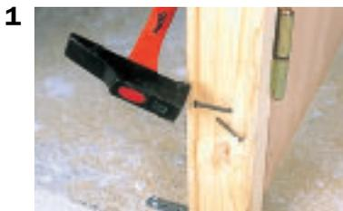
**1. "Larder" les chants du bâti dormant en plantant des clous en travers, pour une meilleure liaison avec les carreaux de plâtre.**
