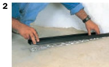
**2. Dans les pièces "humides", coller au mastic un U en plastique qui évitera les remontées d'humidité.**
