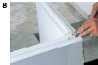
**8. Dans un angle, les carreaux doivent se croiser afin d'obtenir une résistance satisfaisante. Supprimer la languette du carreau en place, sur une épaisseur de carreau, pour faire reposer le carreau perpendiculaire du rang suivant.**
