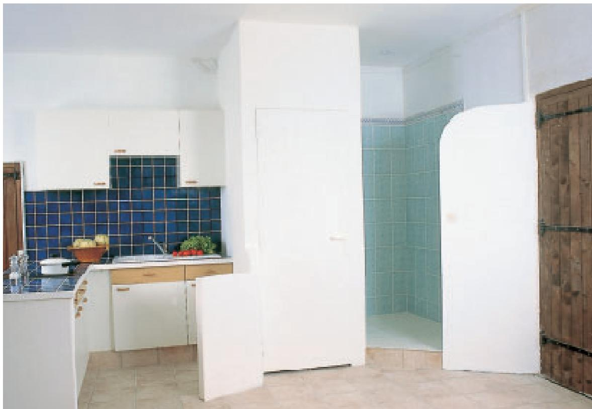
**L**e carreau de plâtre est un matériau très pratique pour les travaux d'aménagement. Résistant, facile à travailler et à décorer, on l'utilise pour construire des cloisons fermées ou non, des supports d'évier ou des plans de travail, des montants de bibliothèque, pour habiller une baignoire ou des canalisations, etc.
